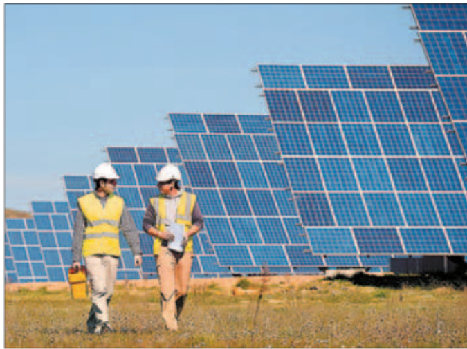
Dos técnicos inspeccionan una planta solar fotovoltaica en suelo.
