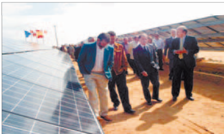
Inauguración de una planta solar fotovoltaica en Salamanca.
