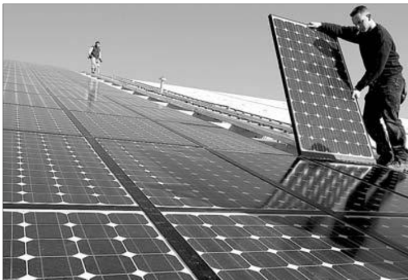
Dos trabajadores instalan una planta solar fotovoltaica.
